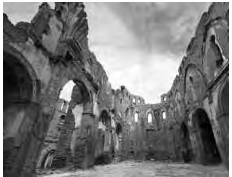
Sotto: Una chiesa completamente distrutta.
