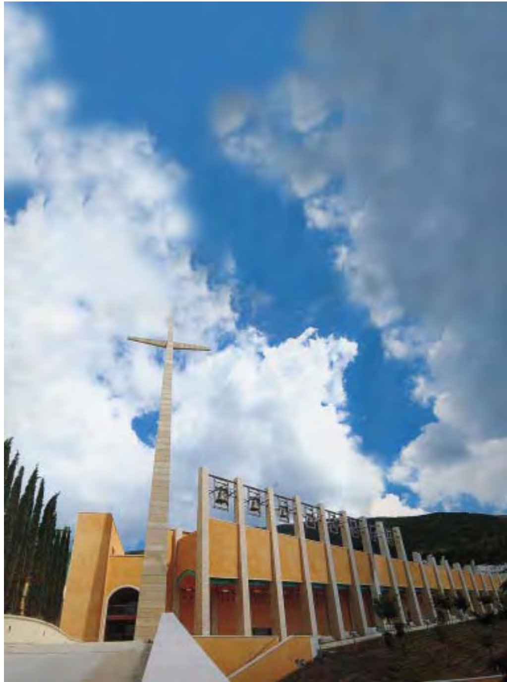
Il grande muro del corridoio e del sistema campanario .
