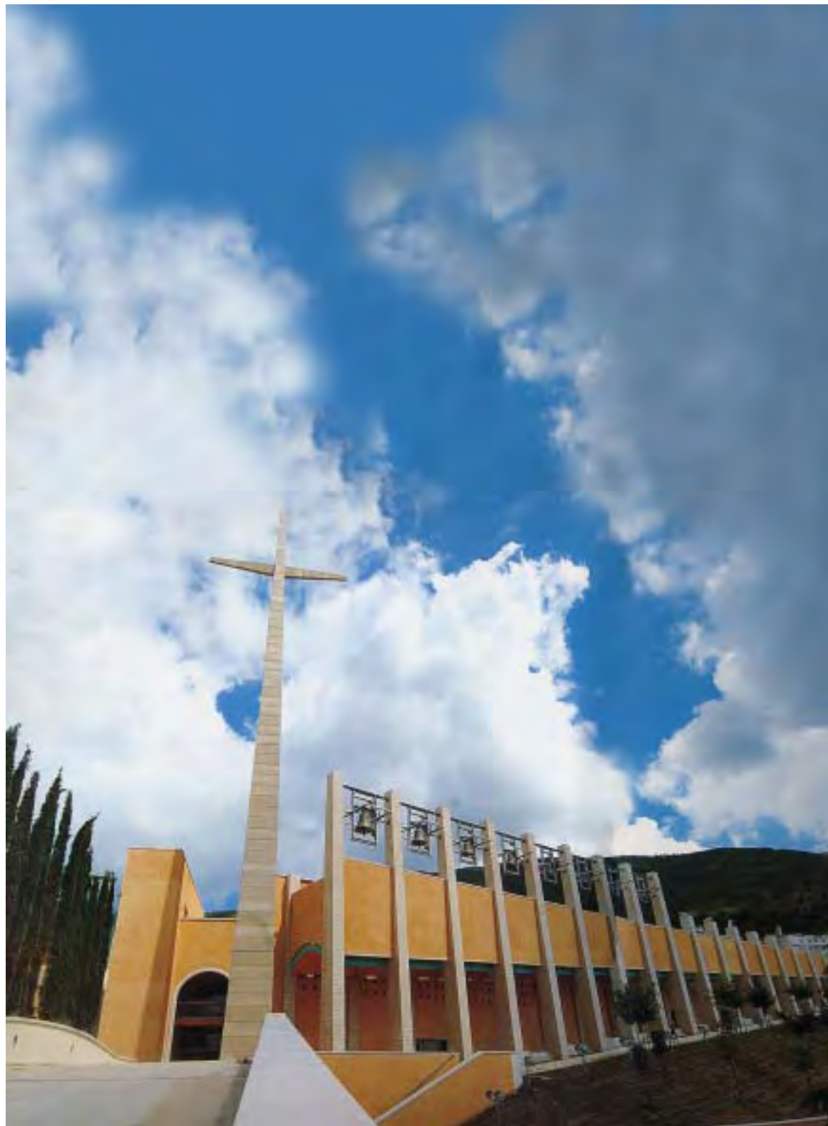
Le grand mur du couloir et du système campanaire.
